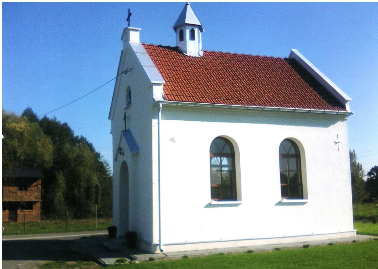
Na zdjęciu: Kaplica pod wezwaniem św. Zofii w Rudce, wybudowana w latach 1910 – 1911 stan po remoncie w 2020r.
